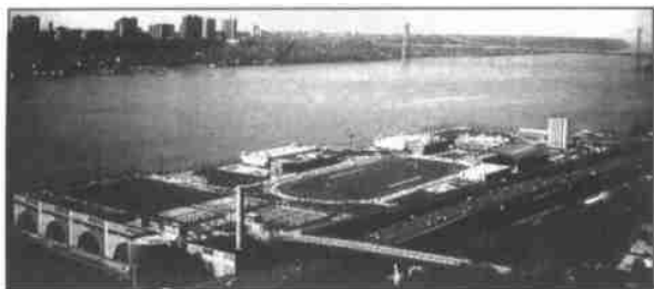
图3 滨河公园污水处理厂的屋顶改造为体育场
